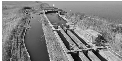
t 本流の堰 せき のそばに設置された流路
