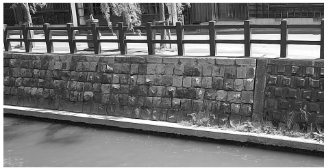
s 石材を用いて整備された護岸
