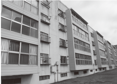
地区 d 市中心部の社員用住宅地区
