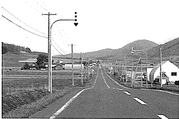
③ 道路の境界を示す 標識
