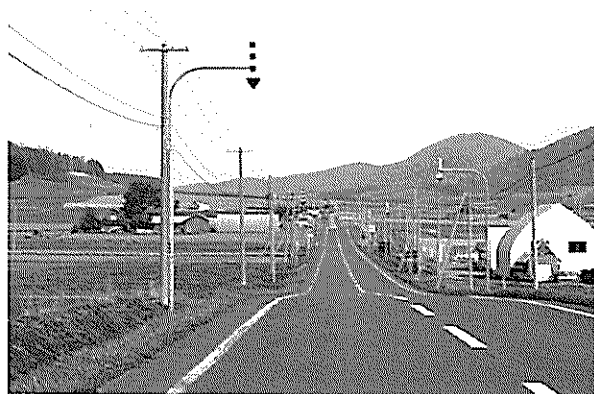
③ 道路の境界を示す 標識
